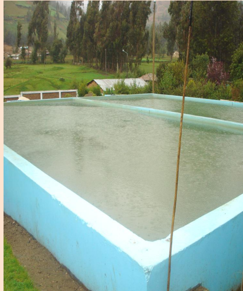
Filtro I y Filtro II de Almacenamiento de Agua Refaccionados
