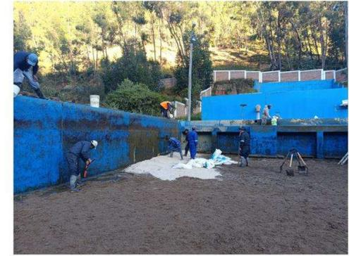
**MANTENIMIENTO Y CAMBIO DEL LECHO FILTRANTE N°1 CON SÍLICE.**
