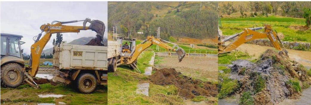
**EXTRACCIÓN Y REMOCIÓN DE LODOS CON MAQUINARIA PESADA EN LA PLANTA DE TRATAMIENTO DE AGUAS RESIDUALES (PTAR)**
